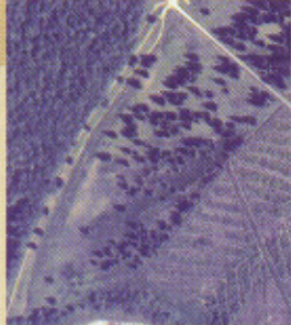
Réseau de drains en plantation d'épicéas
