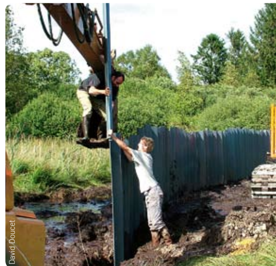
Construction d'une digue en palplanches
