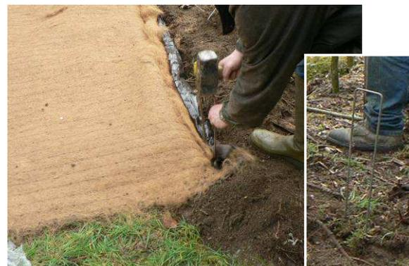
Photos 78 - 79. Positionnement d'une bâche agricole (gauche) ou d'une nappe de paillage (droite). Fixation du pourtour de la bâche dans une tranchée de 15 cm de profondeur à l'aide d'agrafes de fixation. Superposition des bandes successives.
