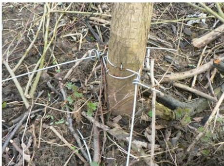
Photo 69. Fixation du fil de fer galvanisé aux piquets.
