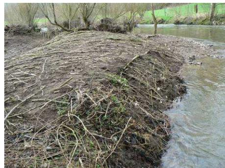
Photo 72. Tapis vivant de saule, réalisé sur berge, après talutage.
