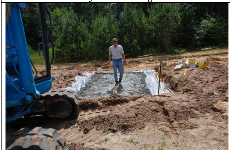
Construction de cattle grid à Lagland afin de permettre un passage permanent des engins militaires dans les enclos fixes
