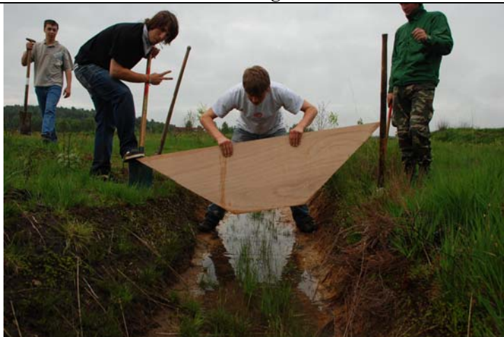
Bouchage de drains à Lagland
