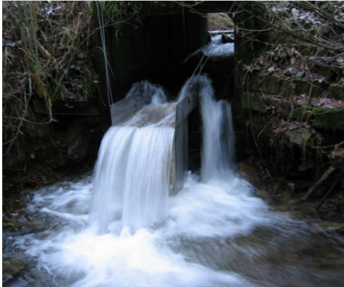
Figure . Aperçu du piège de montaison situé au Franc-Ry en aval du passage sous voirie.
