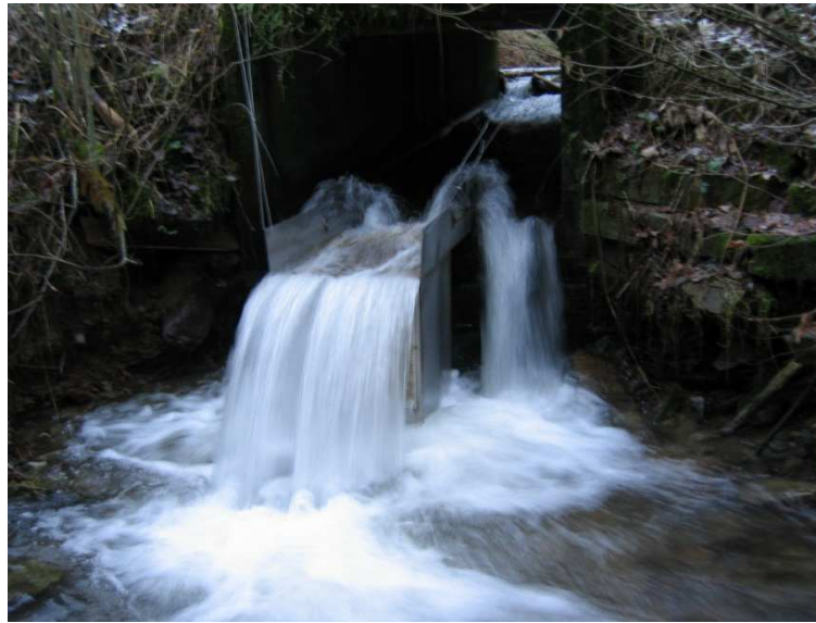
Figure . Aperçu du piège de montaison situé au Franc-Ry en aval du passage sous voirie.
